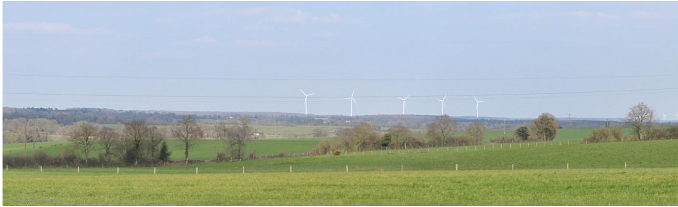
Topographie faisant ressortir l'élancement des éoliennes
