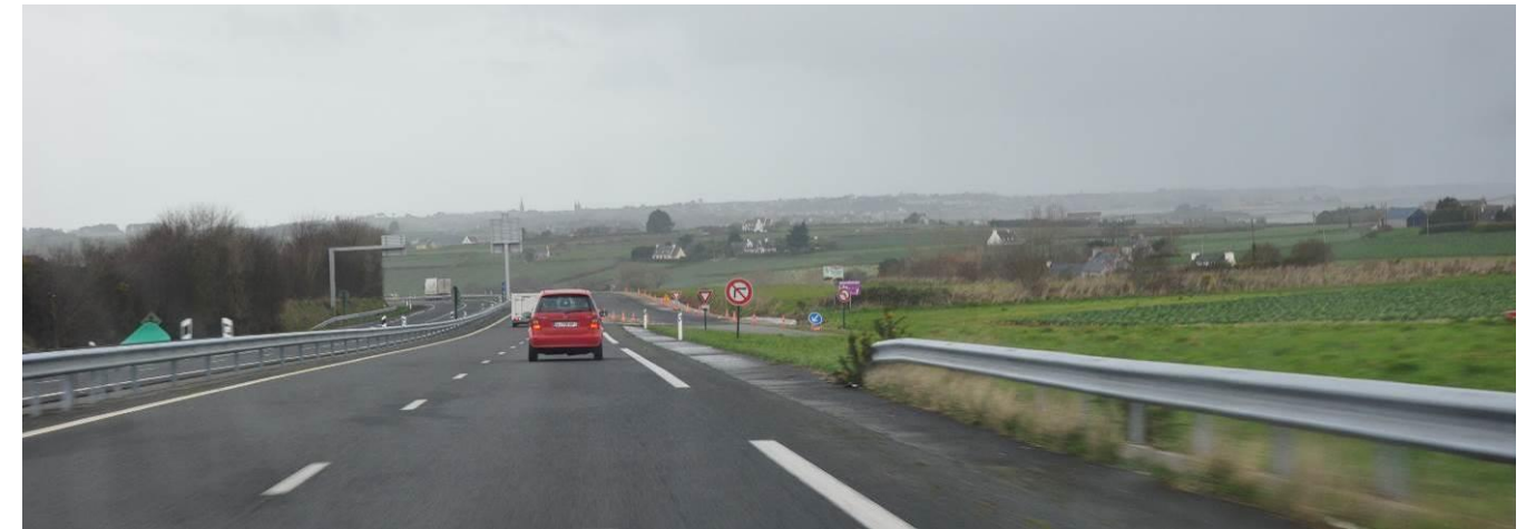
La RN12, une voie de passage dans le plateau légumier du Léon
