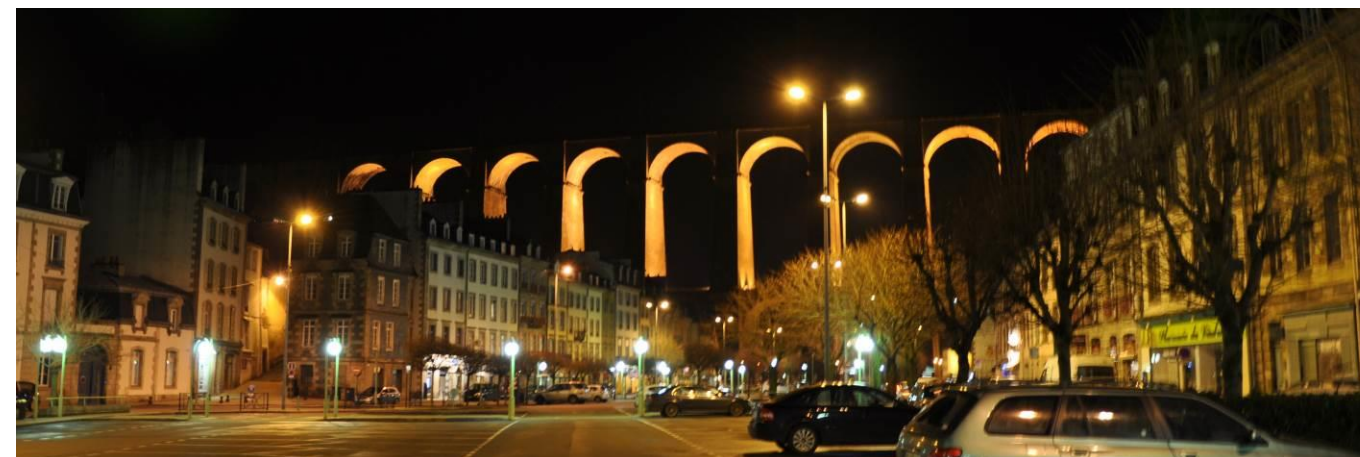
Viaduc de Morlaix, édifice monumental traversant la vallée
