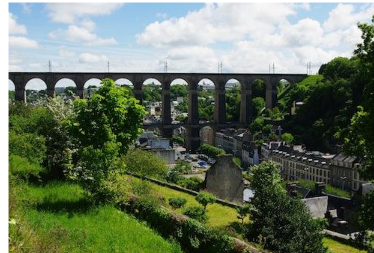
Vue de Morlaix depuis les hauteurs (Source : http://www.tourisme-morlaix.fr/viaduc-venelles-morlaix-bretagne.html )
